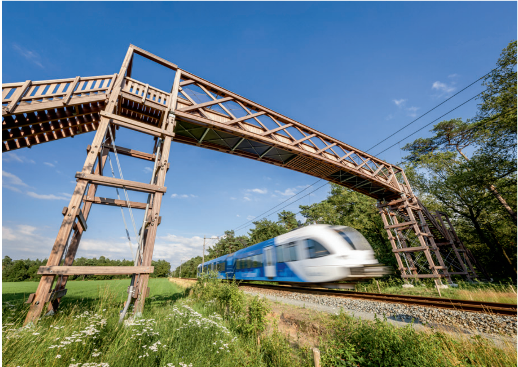
Spoorbrug, Vilsteren (NL)
