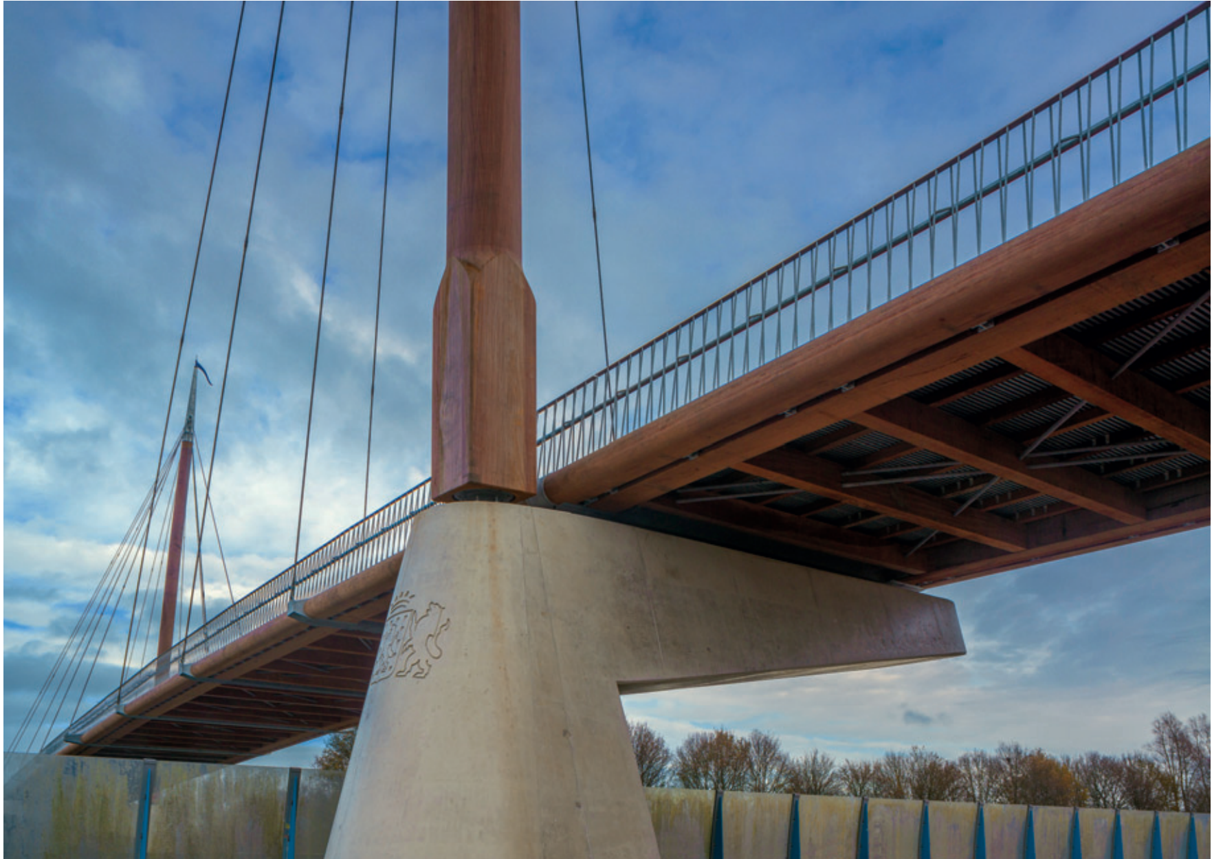
Brug, Harderwijk (NL)
